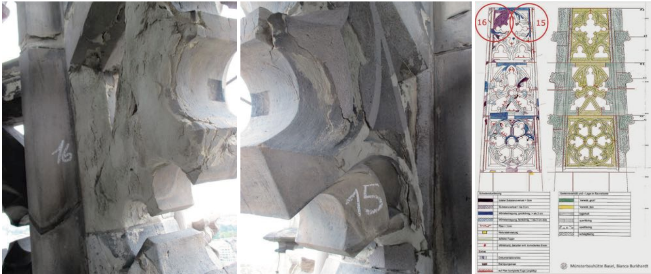
Abb. 8 Kartierungen von Schäden und Gesteinsvarietäten, Fotos und Zeichnung Stiftung Basler Münsterbauhütte
