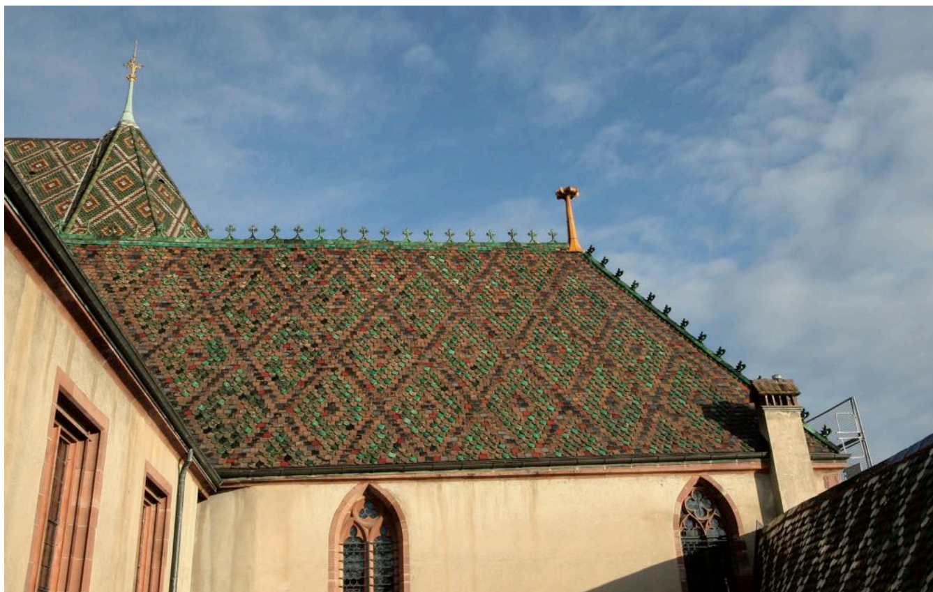
Abb. 4 1987–89, Dach der Niklauskapelle Seite Kreuzgang mit 85% originalen und 15% neuen, handgefertigten glasierten Ziegeln
