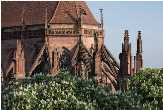
Abb. 3 Ansicht Pfeileraufsätze von Südosten, 2013
