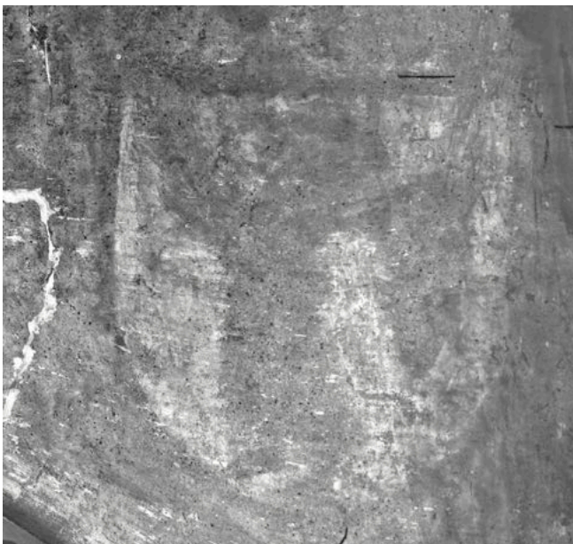
Abb. 13 Basel, Münster, Münch-Wappen im Gewölbe des Orgeljochs (vgl. Abb. 12). Foto Erik Schmidt
