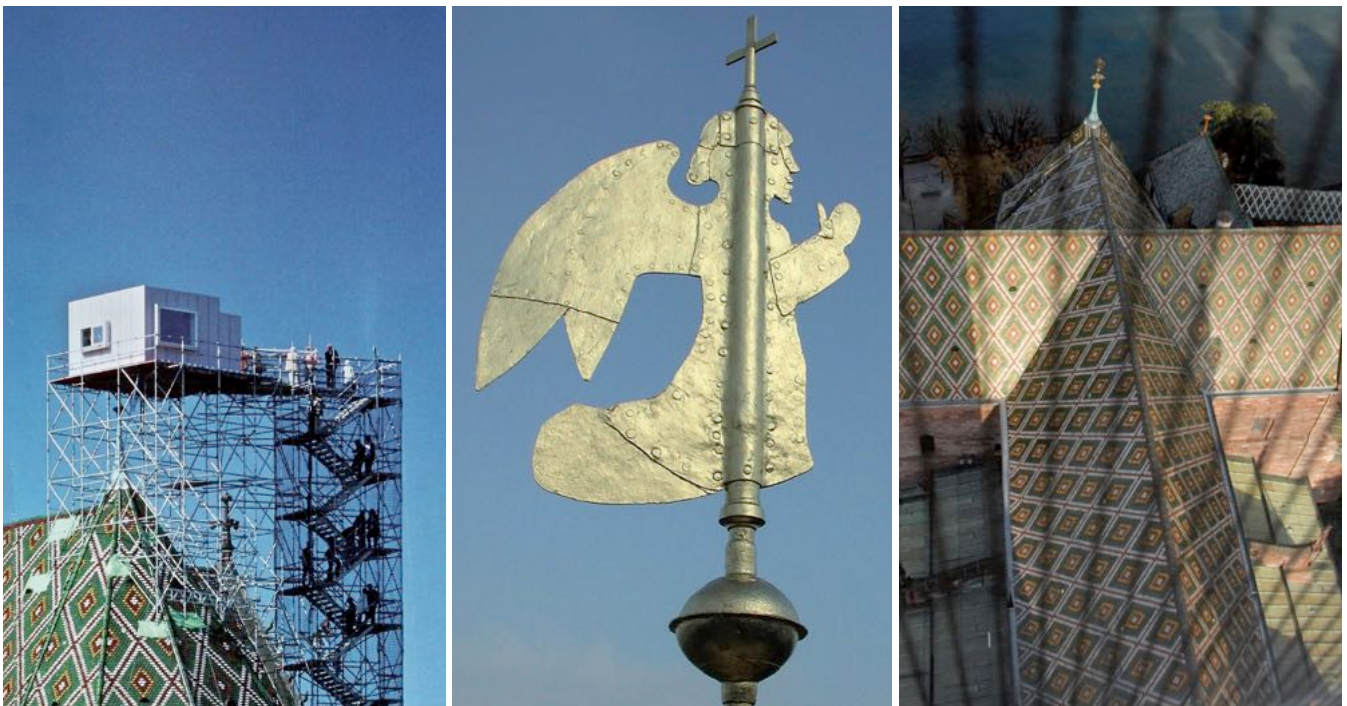
Abb. 7 Links: 2002, Kunstinstallation «Engel» auf Hochchor, von Tazro Niscino. Mitte: 2002, Engelwetterfahne nach der Restaurierung. Rechts: 2003, Dachaufsicht vom Gerüst des Georgsturms
