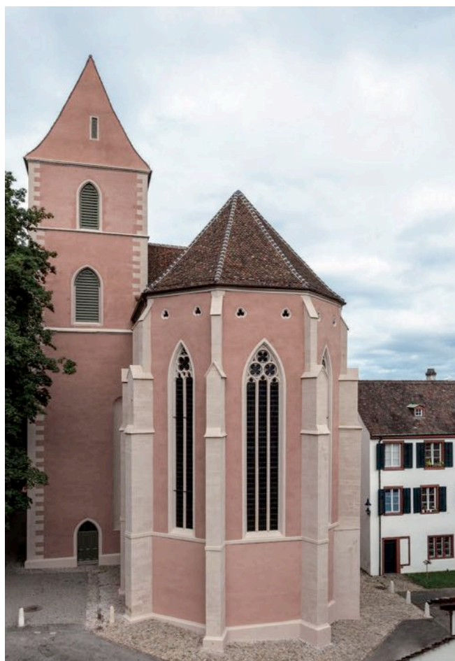
Abb. 9 Stiftung Basler Münsterbauhütte, Restaurierung St. Albankirche 2012–13, heute genutzt durch die Serbisch-orthodoxe Kirchgemeinde. Foto Peter Schulthess Basel
