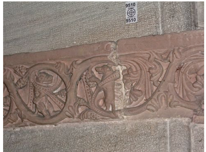
Abb. 5 Basel, Münster, Krypta, Rankenfries. Der Anschluss der beiden Werkstücke bezeugt eine Reparatur: Links ist die Ranke belegt, rechts nur noch vegetabil; die Versatzmarke auf der Deckplatte des linken Werkstücks findet rechts kein Gegenüber. Foto, Archiv des Verfassers
