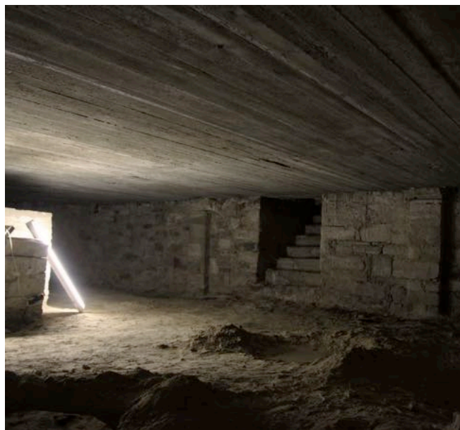
Abb. 5 Norbertgrablege vor Baubeginn, 2015. Foto HARTKOPF denk mal architektur
