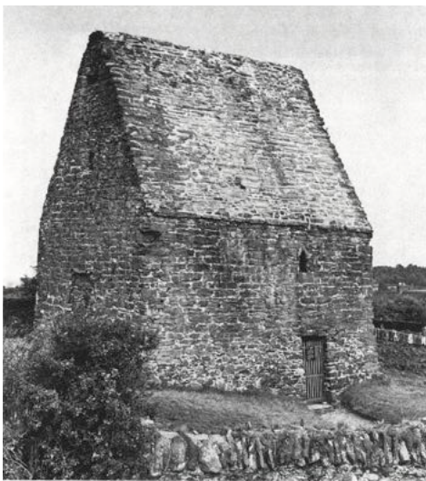
Abb. 2 Alte Steinkirche in Kells, Irland. «Haus des heiligen Columcille». Das Mauerwerk zeigt die Elemente der keltischen Steinsetzung deutlich. Zum Mauerwerk wurde es durch Hinzufügen des Mörtels. Dietrich Conrad, Kirchenbau im Mittelalter, Edition Leipzig, 1990, Verlagsarchiv
