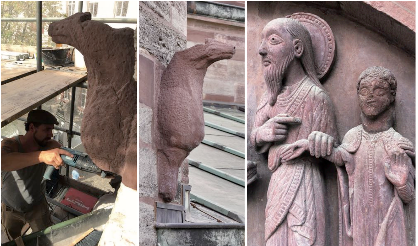
Abb. 9 Versetzen der im Mörtelgussverfahren erstellten Kopie und Ausschnitt Tympanon mit Paulus und der weiblichen Stifterfigur mit Mörtelköpfchen. Fotos Stiftung Basler Münsterbauhütte
