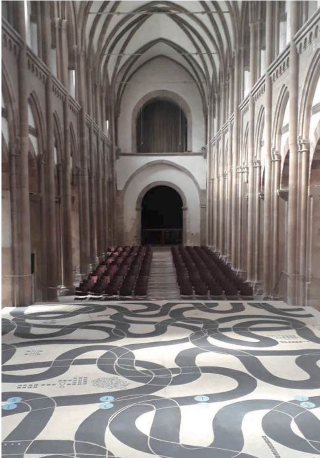
Abb. 8 Innenraum nach Westen mit erhöhtem Veriungsbereich im Vordergrund. Die Grafik wurde im Estrich hergestellt durch Materialaustausch analog der historischen Technik der Inkrustierung. Foto HARTKOPF denk mal architektur
