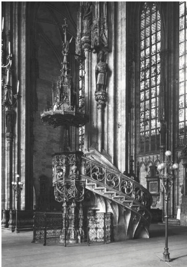
Abb. 1 Gaskandelaber im Langhaus. © Archiv der Dombauhütte
