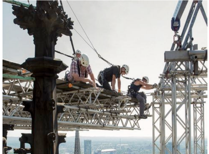
Abb. 8 Gerüstbau am Kölner Dom
