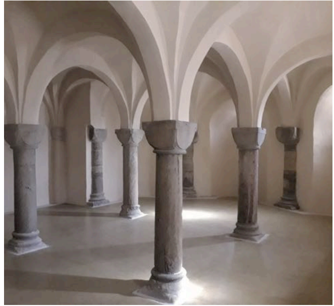
Abb. 7 Krypta nach Fertigstellung der Baumaßnahme, ältester Bauteil der Klosterkirche um 1024. Fotoarchiv des Kunstmuseums
