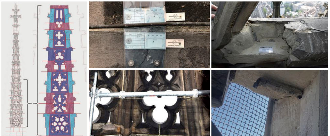
Abb. 3 Analysen zum Steinschnitt, Rissmonitore und Sondierungen. Zeichnung und Fotos Barthel & Maus
