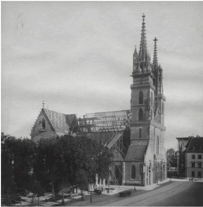
Abb. 5 Münster-Dachrenovation 1887. Foto StABS, Neg. 6498; Kantonale Dpfl.BS, Hermann Ochs 1887; StABS, Georgsturm mit Gerüst, Wolf Neg. 942
