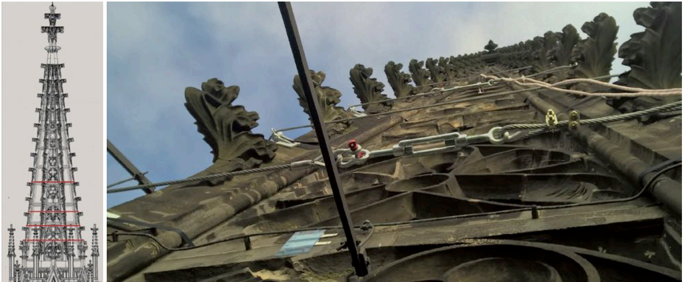
Abb. 2 Notsicherungsmaßnahmen am Turmhelm 2016. Zeichnung und Foto Stiftung Basler Münsterbauhütte
