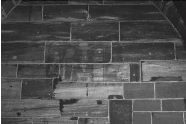
Abb. 1 Im Nordosten des ehemaligen Chorflankenturms schloss sich ein doppelgeschossiger Anbau mit Sakristei und Schatzkammer an. Links des ursprünglich über die Hochchorumgang erreichbaren oberen Zugangs (erkennbar an den sich dunkel abzeichnenden Austauschquadern unten rechts) sind die Umrisse eines von Maria, Johannes und weiteren Figuren flankierten Gekreuzigten (H.67, B. 132 cm) abzulesen (UV-Aufnahme). Foto Stiftung Basler Münsterbauhütte
