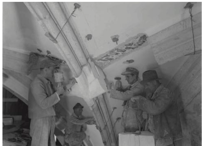
Abb. 7 Arbeiten an den Gewölberippen nach 1945
