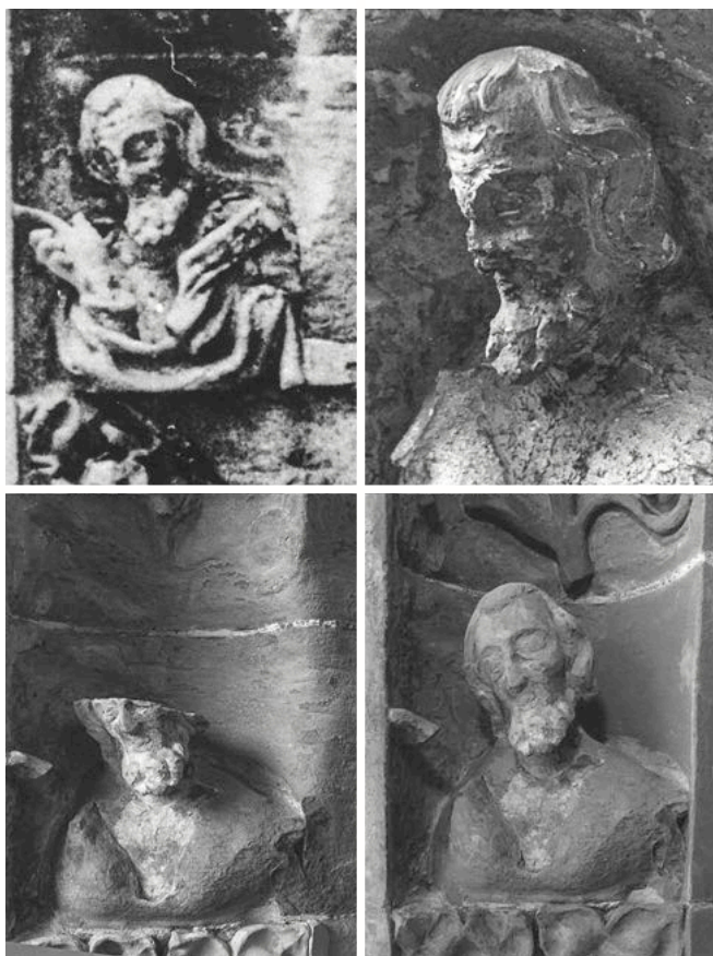
Abb. 6 Apostelfigur in den äusseren Archivolten, Zustand um 1890, 1930, 1970, 2016. Bildzusammenstellung Nussli Restauratoren. Photothek Amt für Kulturgüter Freiburg
