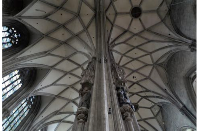
Abb. 5 Netzrippengewölbe mit abgehängten Leuchten. © Archiv der Dombauhütte
