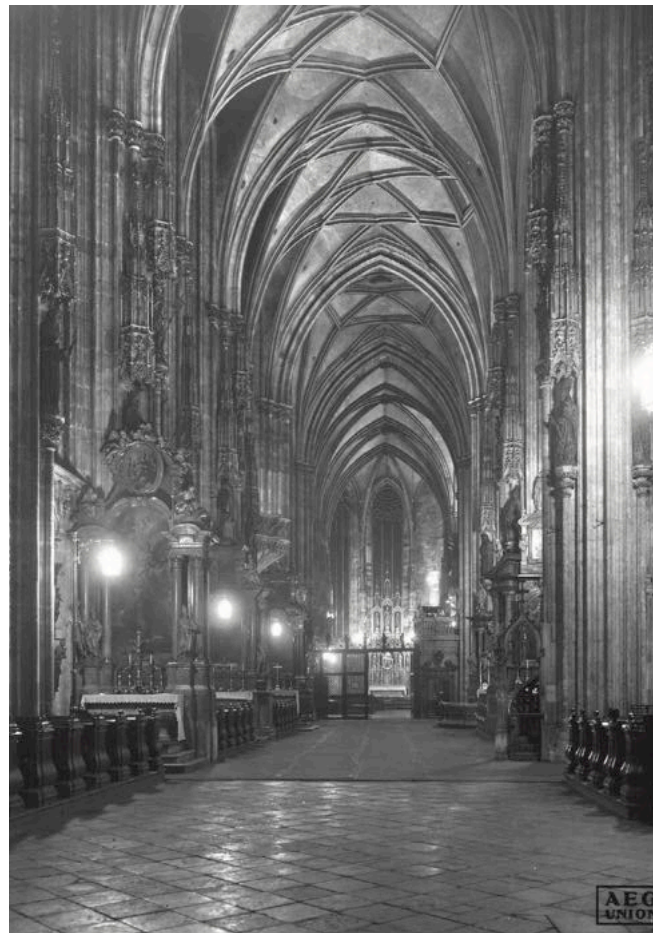
Abb. 2 Elektrische Beleuchtung der Zwischenkriegszeit, Elektrifizierte Kandelaber und Luster. © Archiv der Dombauhütte
