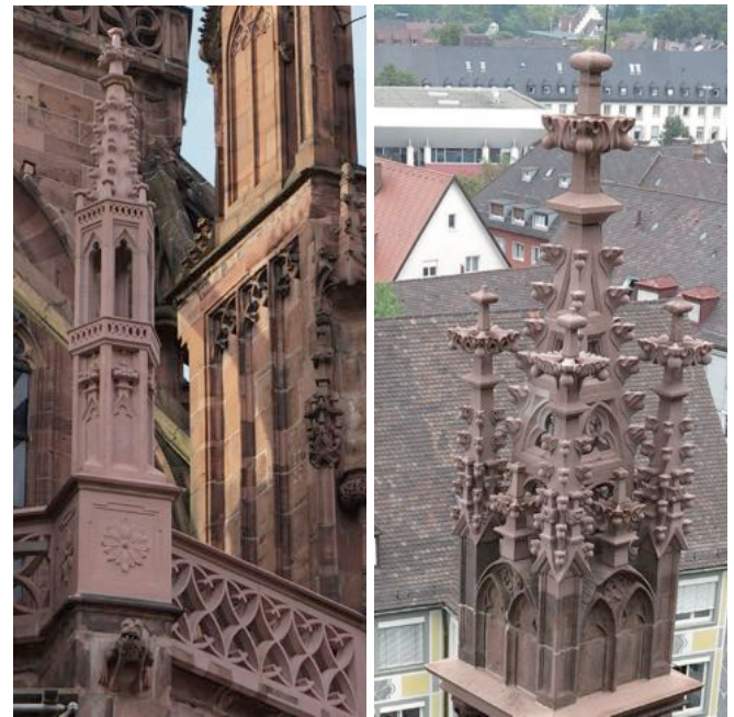
Abb. 6 Neugeschlagener Kapellenpfeiler nach Originalentwurf des 18. Jh.
